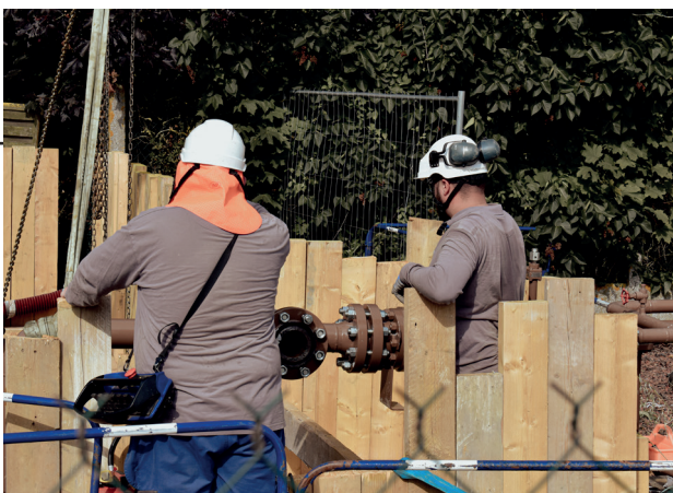
Travaux poste de gaz Rue Ferdinand Capelle
