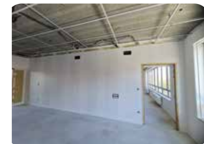
Dernière ligne droite pour le chantier de l'école Victor Hugo.
