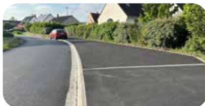
Réalisation de trottoirs rue Cochette
