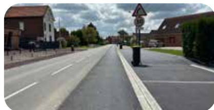
Réalisation de trottoirs rue Victorine Deroide
