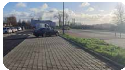
Aménagement d'un parking à l'école Bézéghe
