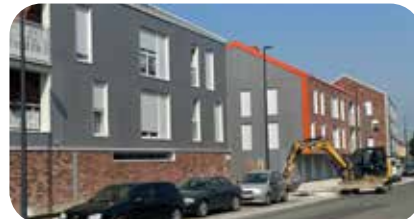
Mise à disposition de 68 logements ce printemps.
