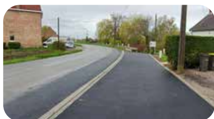
Prolongement des trottoirs rue d'Aire, jusqu'au restaurant « Le Diable au Thym ».
