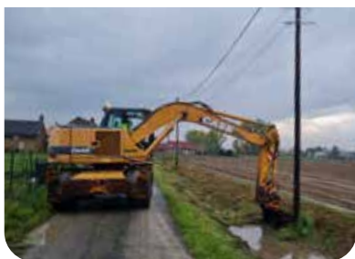
Curage des fossés
