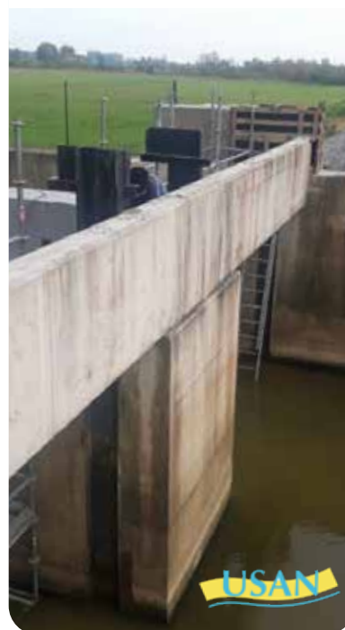
Zone d'expansion de crue
