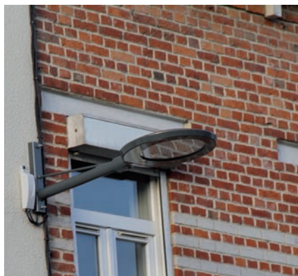
Mise en service progressive de l'éclairage LED et suppression des fils nus, rue des Prêtres, rue Faidherbe et rue Gambetta.
