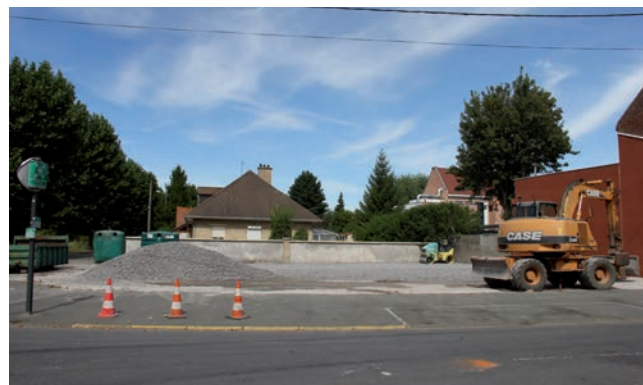
Création d'un parking provisoire à la place de l'ancien arsenal des pompiers.
