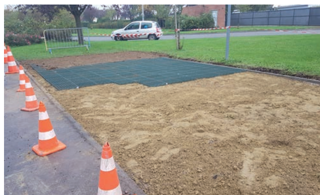
Parking végétalisé, rue du Muguet.
