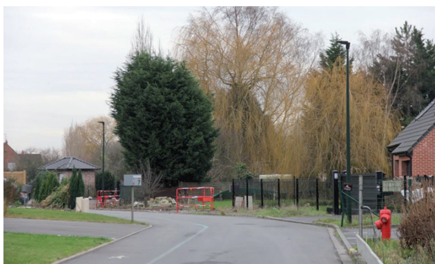
Renforcement de l'éclairage public, rue Georges Laune.
